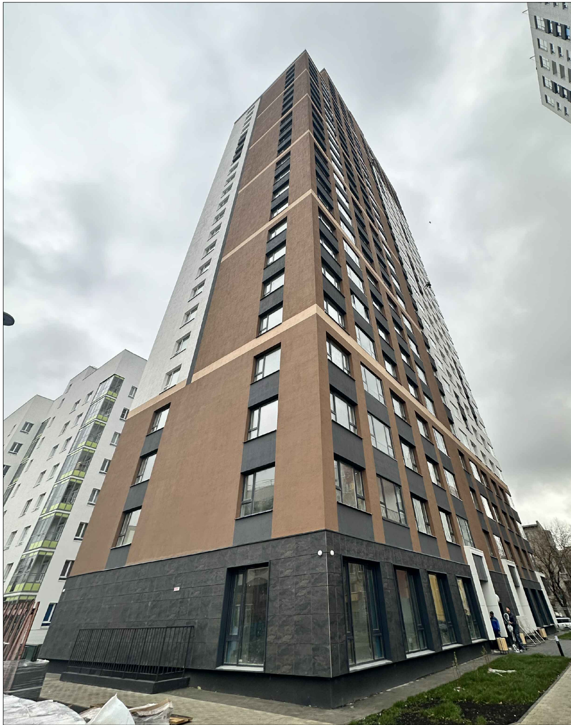
Фасад торцевой со стороны завода СИЗ
